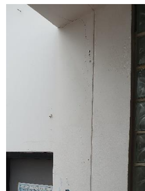
Slika 9 – Dilatacijska reška u prizemlju (lijevo i sredina) i na katu (desno)
