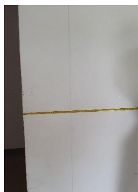
Slika 9 – Dilatacijska reška u prizemlju (lijevo i sredina) i na katu (desno)
